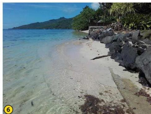
6 Accumulation de sable au pied de l'enrochement
