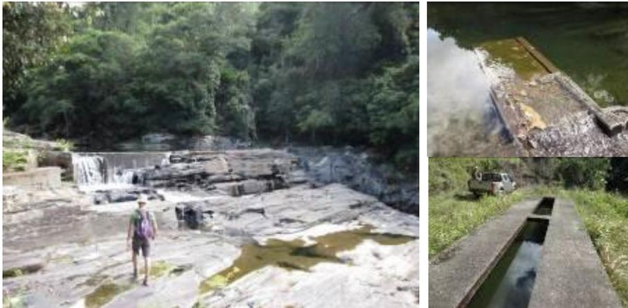
Figure 5. Vue générale de l'ouvrage de captage de Tipwöi (à gauche) et détails sur le dégrilleur (en haut à droite) et sur les bassins supérieurs de décantation (en bas à droite)
