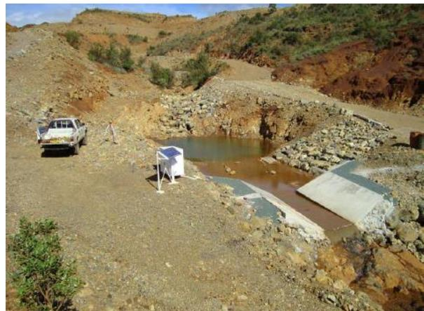
Figure 14. Exemple de station hydrométrique – Poro seuil amont (projet Hydromine – source UNC)
