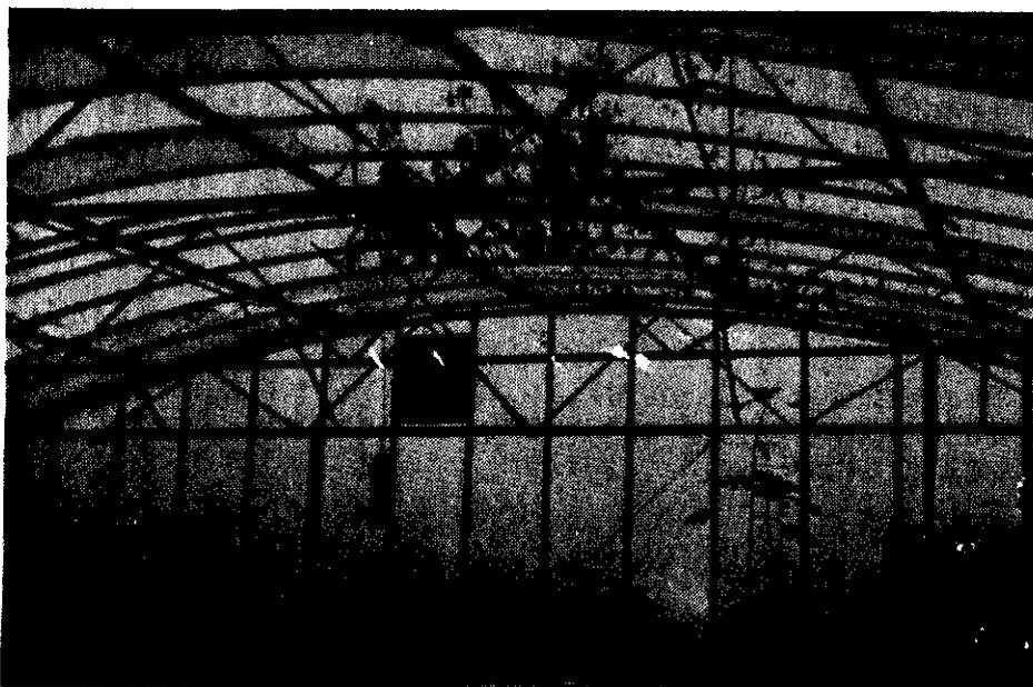
Figure 3 : Vue de l'intérieur de la station de quarantaine à l'importation, à Port-Vila (Vanuatu). Noter les panneaux manquants et cassés sur la toiture.
