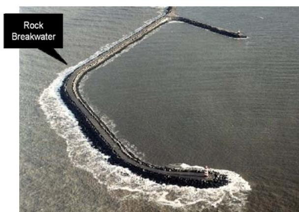
Figure 6.14 : Digue enrochée classique
