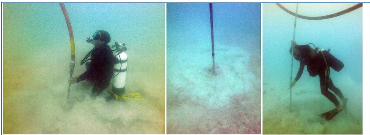
Figure 27 : Illustration de la technique du lancement sur les sites des Gambier
