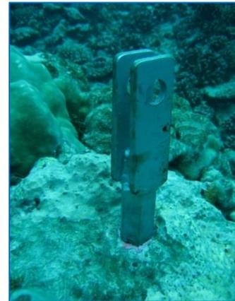
Figure 3 : Tirant d'ancrage dans un substrat corallien
