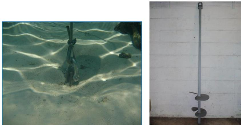
Figure 2 : Mise en œuvre d'un ancrage écologique de type Manta Ray® et exemple d'ancre hélicoïdale (Alunox Marine)
