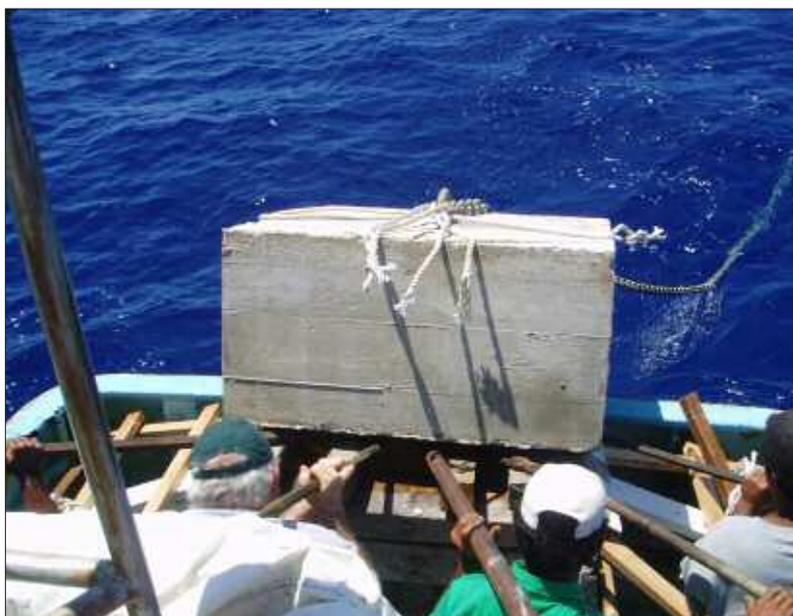
**Mouillage du corps mort (un bloc de béton de 2 tonnes)**
