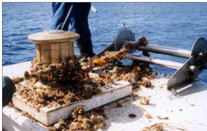
jusqu'à ce que le cordage soit tendu. La ligne de mouillage est ensuite débarrassée, lors de la remontée, des organismes marins et des lignes de pêche qui l'encombrent (figure 14). Une fois le cordage vérifié et les réparations nécessaires effectuées sur la ligne de mouillage ou les pièces de liaison supérieures, le cordage est relâché petit à petit et le système de bouée remis à l'eau.
